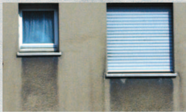
Verschmutzte Fassade
