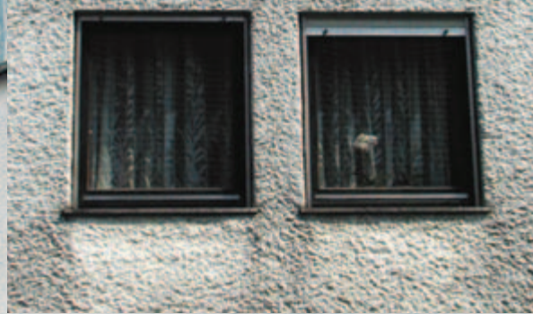
Verschmutzte Fassade
