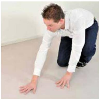
1. Vor dem Verlegen muss der Untergrund dauerhaft trocken, fest, tragfähig und eben sein. Wenn nötig, müssen Höhenunterschiede ausgeglichen werden.
