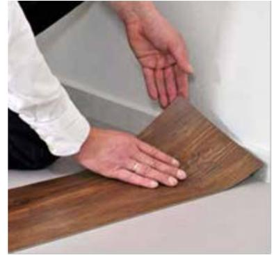
6. Legen Sie das zugeschnittene Element passgenau ohne Stauchung an die Wand an.
