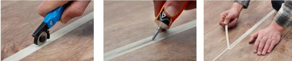
Eine **thermische Verschweißung** ist frühestens 24 Stunden nach der Verklebung mit dem passenden Schweißdraht und der 5 mm-Spezial-Schnellschweißdüse für polyurethanbeschichtete Bodenbeläge bei einer Temperatur von ca. 400 °C durchzuführen. Zum Ausfräsen der Naht ist ein parabelförmiges Diamant Fräsblatt mit 3,3 mm Breite zu verwenden. Die Naht wird 2/3 tief der Nuttschichtstärke gefräst.
