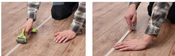
Dieses Klebeband wird nun exakt im Verlauf der Naht aufgetrennt. Dafür empfehlen wir ein Rollmesser zu benutzen. Danach sollte das Klebeband noch einmal angerieben werden. Es wird empfohlen, die Naht mit einem Heißluftgerät etwas vorzuwärmen damit die Nadel des Kaltschweißmittels tief in die Naht eindringen kann. Etwa 10 Minuten nach der Verschweißung wird dann das Klebeband mit dem überschüssigen
