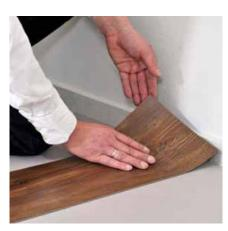
6. Legen Sie die zugeschnittene Planke passgenau ohne Stauchung an die Wand an.
