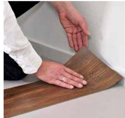
6. Legen Sie die zugeschnittene Planke passgenau ohne Stauchung an die Wand an.
