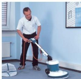
Abschließend wird der Teppichboden mit einem Bürstsauger abgesaugt, um den Pol aufzurichten und zu parallelisieren.
