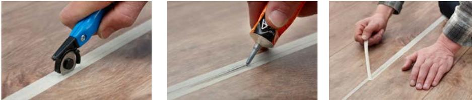
Eine **thermische Verschweißung** ist frühestens 24 Stunden nach der Verklebung mit dem passenden Schweißdraht und der 5 mm-Spezial-Schnellschweißdüse für polyurethanbeschichtete Bodenbeläge bei einer Temperatur von ca. 400 °C durchzuführen. Zum Ausfräsen der Naht ist ein parabelförmiges Fräsblatt mit 3,3 mm Breite zu verwenden. Die Naht wird 2/3 tief der Nuttschichtstärke gefräst.
