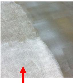
Strukturierte Oberfläche (grobe „Orangenhaut“) nach Auftrag der Haftfixierung mit grobporiger Schaumstoffrolle und vollständigem Abtrocknen.
